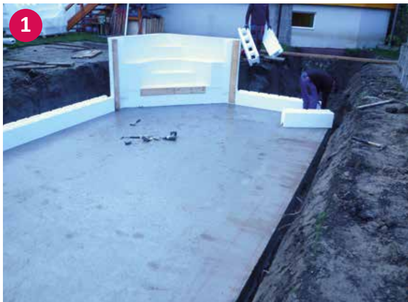
▲ Kotno stopnišče s prvo vrsto stiropornih zidakov
