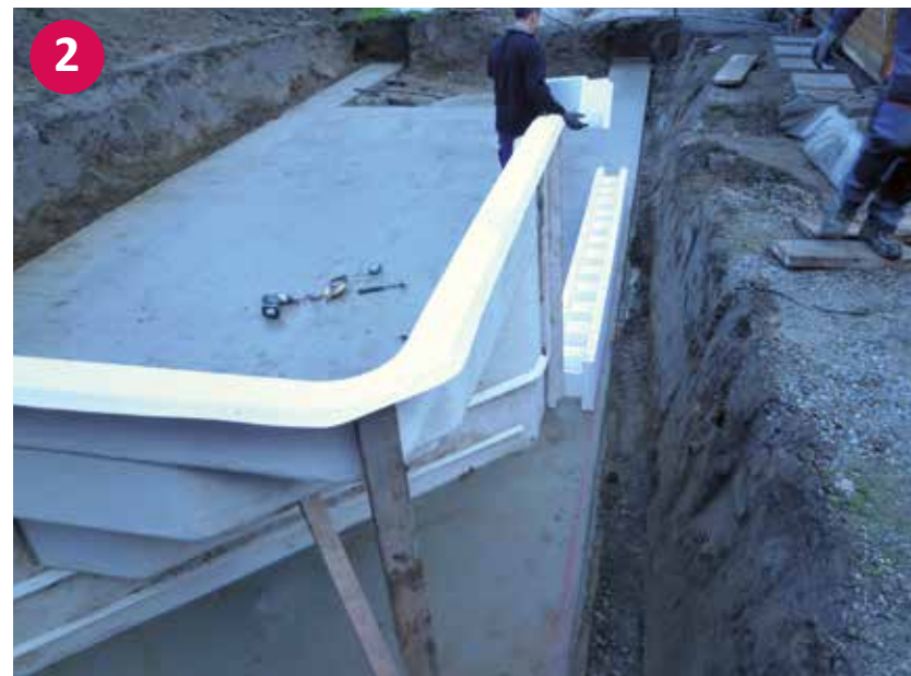
▲ Opora ter navpična in vodoravna namestitve kotnih stopnic
