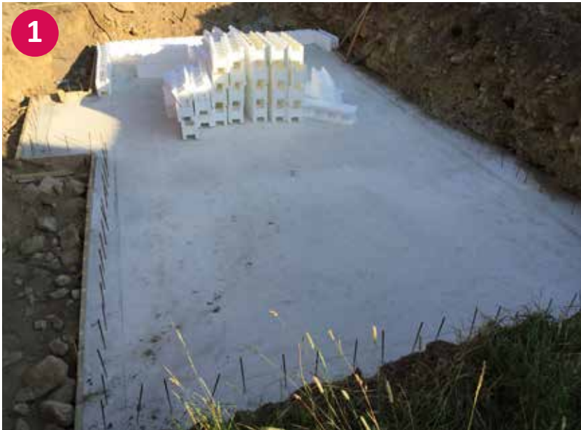
▲ Dokončno posušena talna plošča
