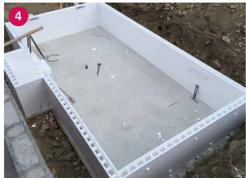
▲ Že sestavljen stiroporni bazen – brez betonskega polnila
