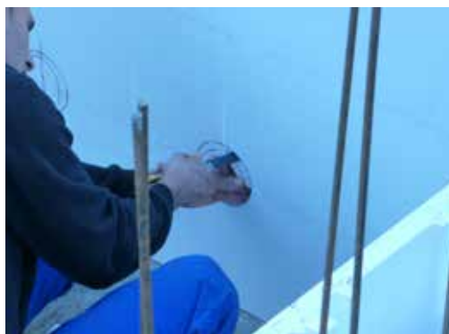
▲ Izrez za dovodno šobo
