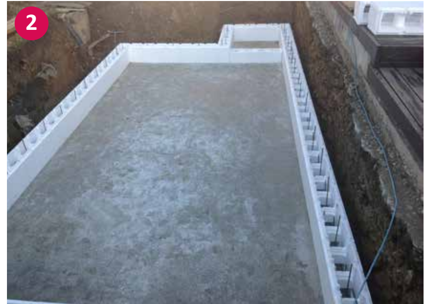
▲ Postavitev prve vrste opek iz stiropora
