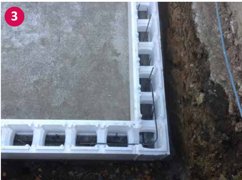
▲ Detajlna slika vogalnega spoja z železno armaturo
