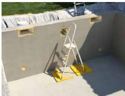
▲ Dokončana in zglajena notranja stena
