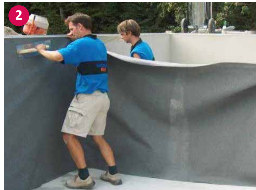
▲ Točkovna pritrditev ločevalne plasti iz flisa z lepilom za stiropor
